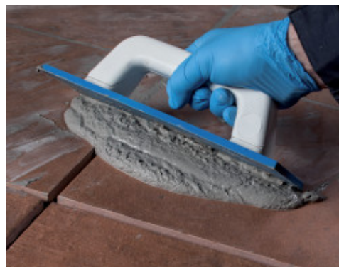
Jointoiement des carreaux avec Ultracolor Plus
