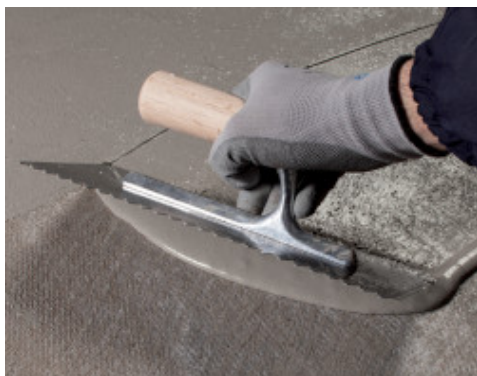
La seconde couche de Mapelastick Turbo sur la première couche renforcée avec Mapetex Sel N
