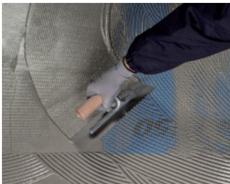
Insérer Mapenet 150 dans la première couche de Mapelastick Turbo encore fraîche
