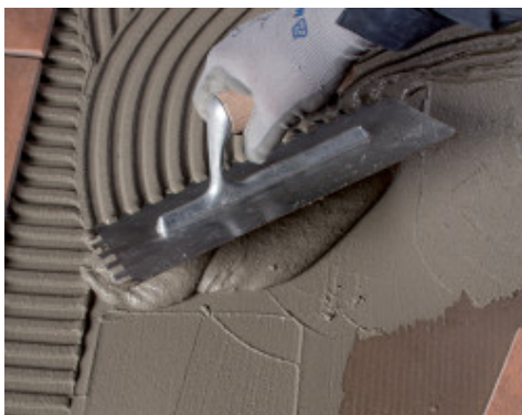
Insérer Mapenet 150 dans la première couche de Mapelastick Turbo encore fraîche
