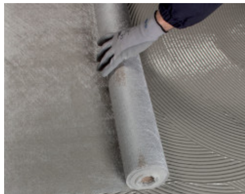
Insérer Mapenet Sel N dans la première couche de Mapelastick Turbo encore fraîche
