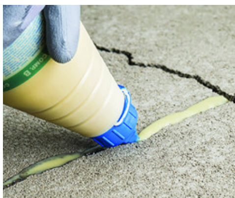
Verser le produit dans la fissure à l'aide de la douille
