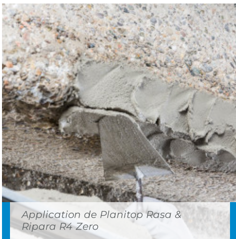
Ragréage de la surface de Planitop Rasa & Ripara R4 Zero à la taloche
