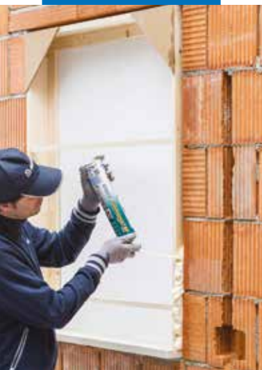
Remplissage des interstices entre un châssis et le mur
