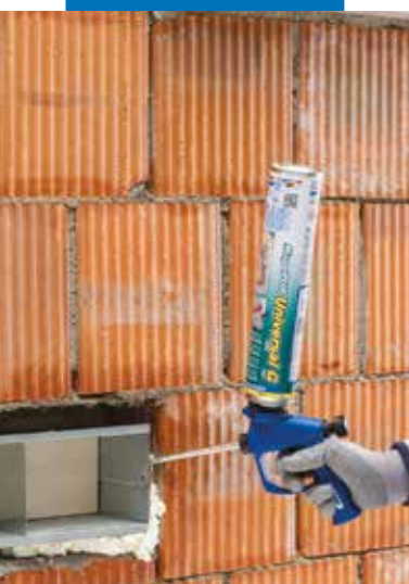
Le remplissage d'un canal d'aération
