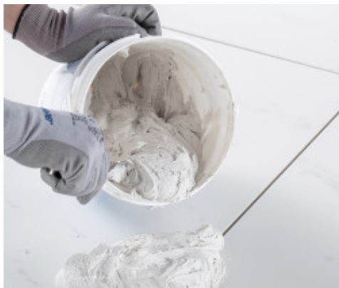
Obtention d'un mélange homogène de consistance crémeuse
