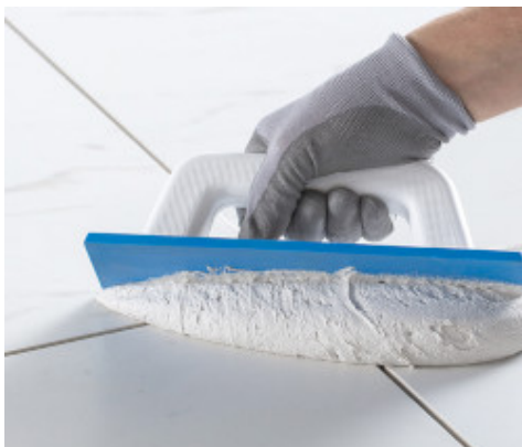
Application de Kerapoxy Easy Design avec la spatule Mapei
