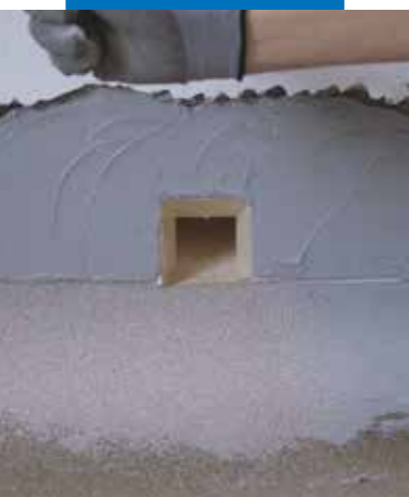
Imperméabilisation de l'écoulement avec Drain Front
