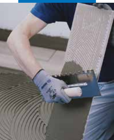
Pose de carrelage ou de pierre naturelle avec un mortier-colle MAPEI adapté de classe C2 au minimum
