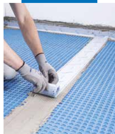
Imperméabilisation des raccords entre les membranes avec Mapeband Easy, collées avec Mapeguard WP Adhesive
