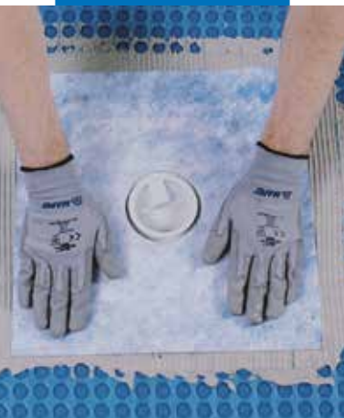
Imperméabilisation de l'écoulement avec Drain Vertical/Drain Lateral
