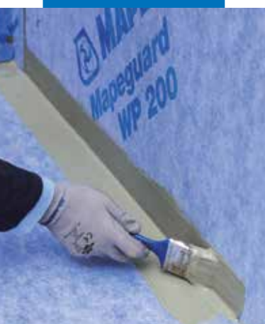
Application de Mapeguard WP Adhesive pour la réalisation de l'étanchéité des angles avant l'application de Mapeguard ST
