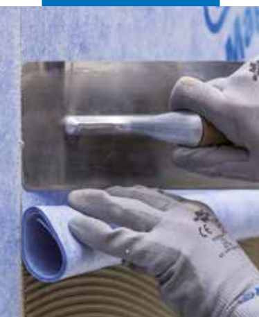
Application de la deuxième membrane
