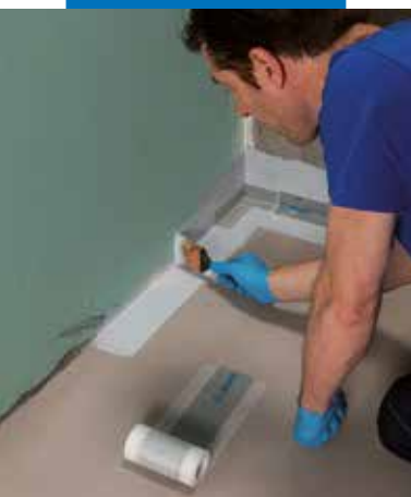
Application de Mapeband PE 120 avec Mapegum WPS
