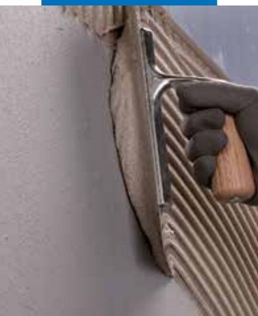
Application de revêtement avec Ultramastic III
