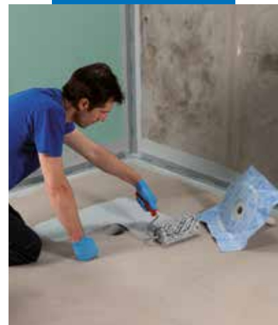
Application d'un drain vertical avec Mapegum WPS
