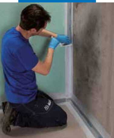
Application de Mapeband PE 120 avec Mapegum WPS
