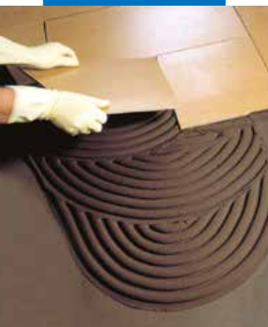
Pose de grès cérame sur une chape imperméabilisée avec Mapelastic
