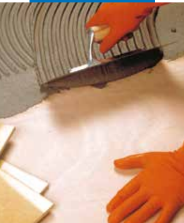
Pose de grès cérame avec Elastorapid sur panneau de bois multicouche marine
